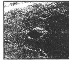
Spalling
