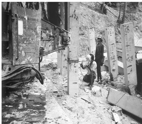
(d) Welding of a precast concrete pile
