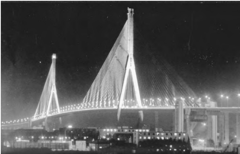
FIGURE 28.11 Yang Pu Bridge, China. (Courtesy of T. Y. Lin International.)
