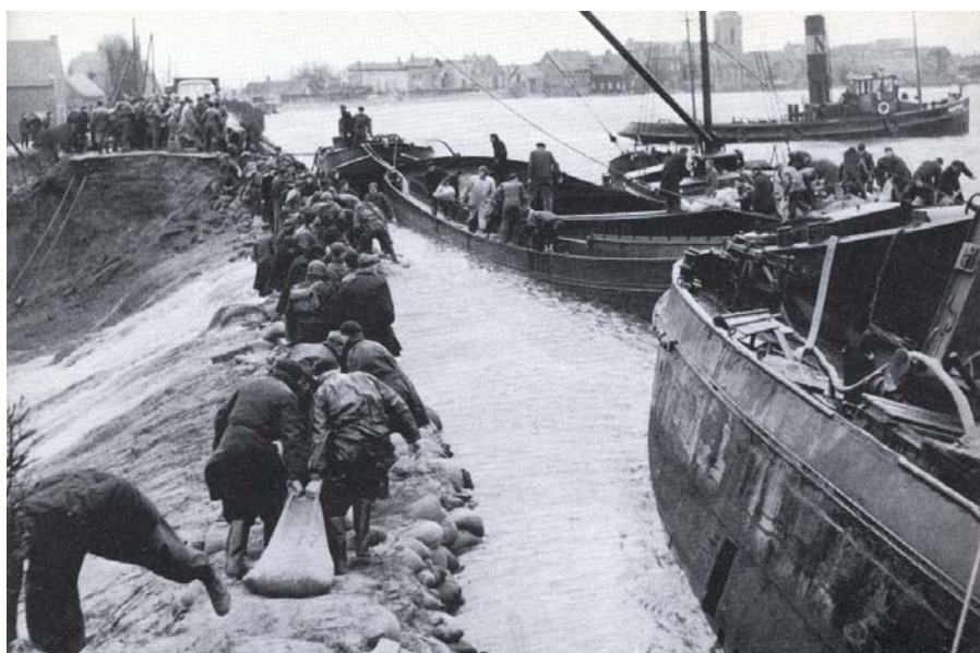
Figure 17-4 Closure dike breach Ouderkerk aan den IJssel 1953
