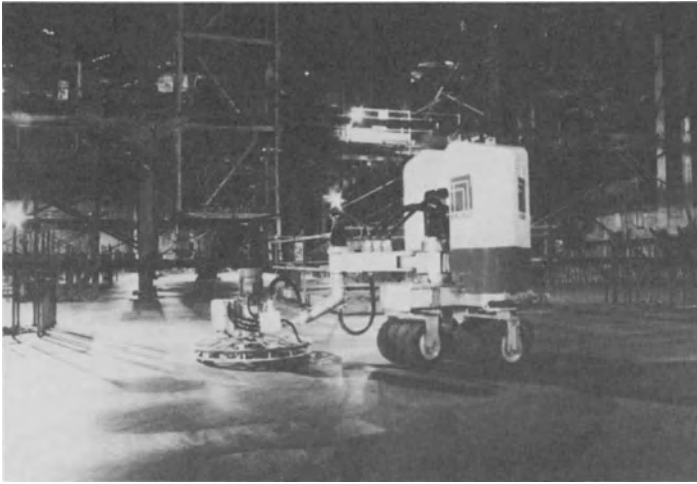
Fig. 18 Concrete slab-finishing robot (Kajima)
