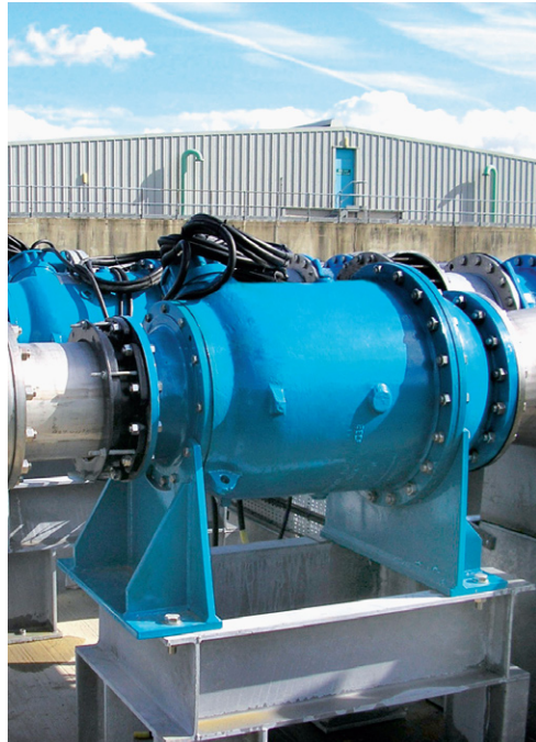
(d) Submersible motor in-line booster pump — 1500 m 3 /h @ 10 m lift. (Bedford Pumps Ltd., UK)
