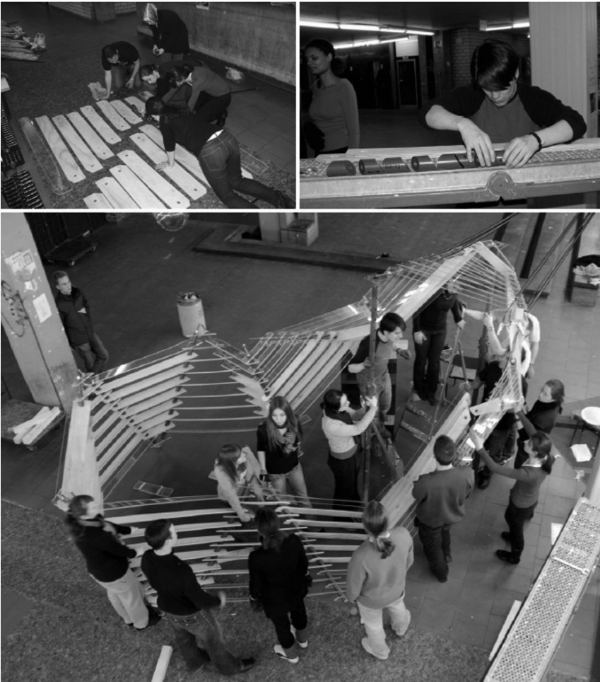
Fig. 10. Pre-assembly of the Möbius strip. Photos courtesy of Technische Universität Darmstadt
