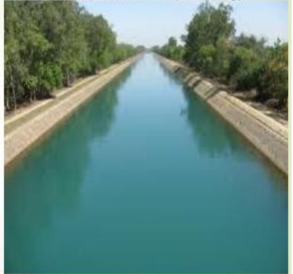
(d). canal without bridge
