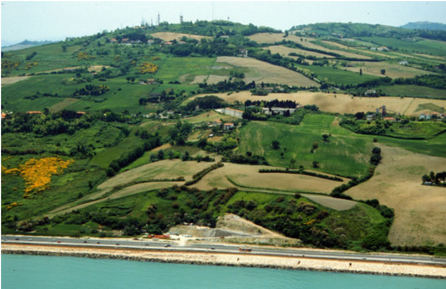
Fig. 7.3 Area of development of the Large Ancona Landslide: to the bottom is Località Barducci; to the top is Località Montagnolo
