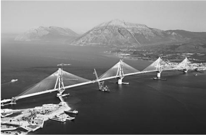
Figure 1.107 Rion-Antirion Bridge. (Photo credit: Francis Vigouroux/Photothèques Vinci et filiales)
