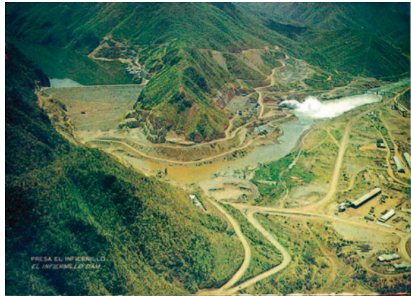
Fig. 18 El Infiernillo dam body view
