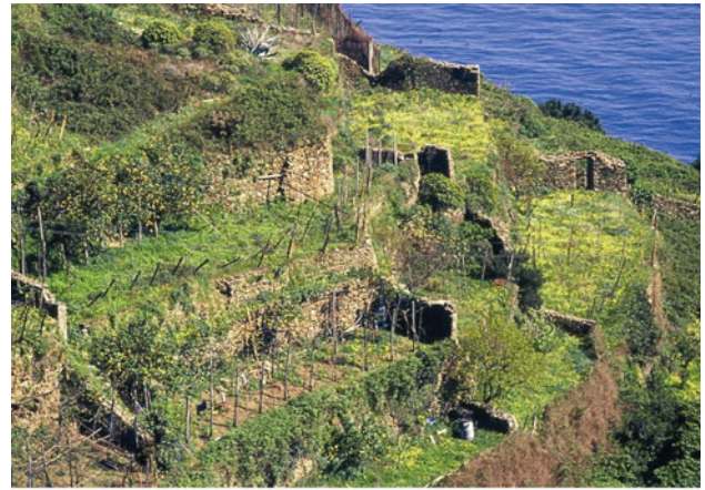
Fig. 4.36 Terrace on slope superior to 100 %. The soil is Escalic Anthrosol. Parco Regionale delle Cinque Terre (Province of La Spezia)
