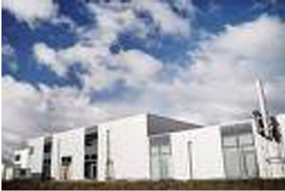
Fig. 7 Sulfurcell pilot plant, Berlin
