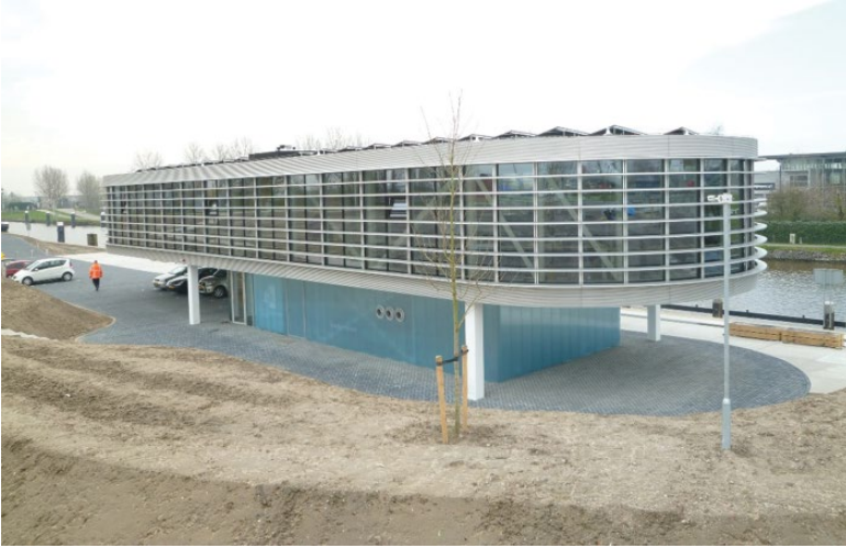
Figure 1 Steekterpoort, Alphen aan den Rijn. © Slimline Buildings.
