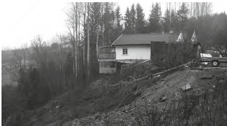
Fig. 1.20 Le argille rapide sono piuttosto comuni in molte zone costiere della Scandinavia. La casa in figura è stata evacuata perché in serio pericolo per questo tipo di rischio. Foto cortesia di May-Britt Sæter
