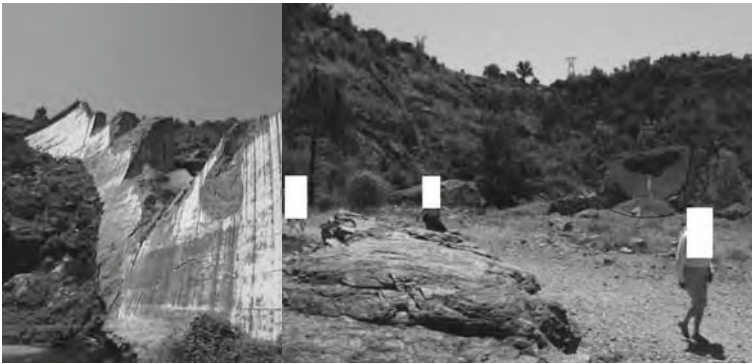
Fig. 1.11 A sinistra: i resti della diga di Malpasset. A destra: grossi massi trasportati dall'acqua durante l'onda di piena. Fotografie originali di Ole Majlede Jensen
