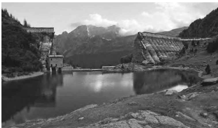
Fig. 1.9 I resti della diga del Gleno in provincia di Bergamo
