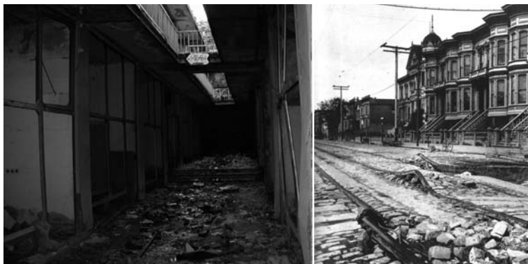
Fig. 2.15 A sinistra: edifici danneggiati da un terremoto in Iran settentrionale nel 1990. Anche se gli edifici rimangono in piedi, singoli blocchi in caduta possono essere pericolosi. A destra: l'accelerazione del suolo durante il terremoto del 1906 ha prodotto queste deformazioni delle rotaie dei tram. Cortesia USGS
