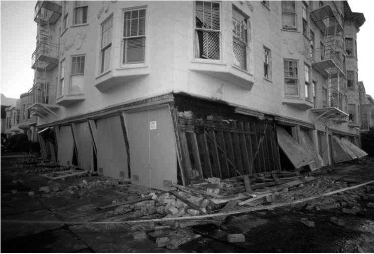
Fig. 2.14 Danni a San Francisco alla base degli edifici causati dal collasso di alcuni garage durante il terremoto di Loma Prieta del 1989. Foto di J.K. Nakata, riprodotto con permesso dell'USGS americano
