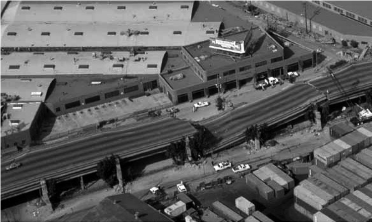
Fig. 2.26 Vista aerea del viadotto dell'autostrada 880 crollato a Oakland (California) durante il terremoto di Loma Prieta del 17 ottobre 1989. Foto di H.G. Wilshire di dominio pubblico, riprodotta con permesso dell' USGS Americano
