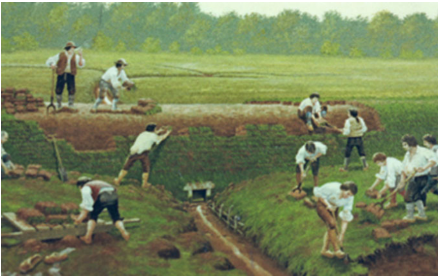
Fig. 4.2 Acadian dyke building in the 18th century. Source Azor Vienneau, Musée de la Nouvelle-Écosse
