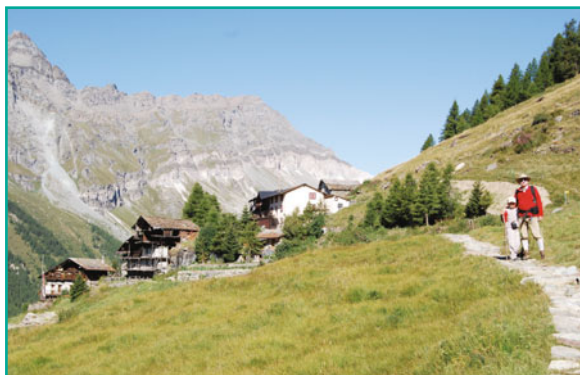
Fig. 9.6 Il villaggio alpino di Resy, in Alta val d'Ayas (2070 m) in cui due baite sono state trasformate in rifugio
