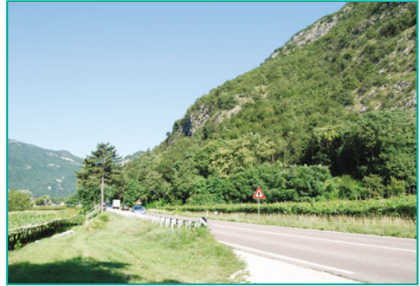
Fig. 14.11 Veduta della strada statale per Riva del Garda vicina al punto di attraversamento più frequente della fauna ungulata, dove sarebbe necessario un sottopasso
