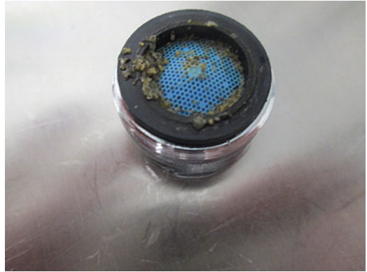
■ Abb. 7.8 Perlator mit Sieb und Granulat
