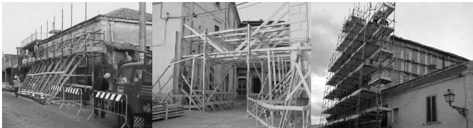
Fig. 16.18. Wooden propping (Etna 2002)
