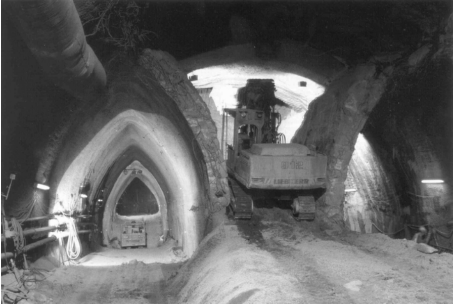
Fig. 4.10. Niedernhausen tunnel, sidewall drift 5
