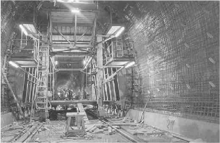
Fig. 5.31. Rolling formwork (Nebenwegtunnel, Vaihingen/Enz) 27
