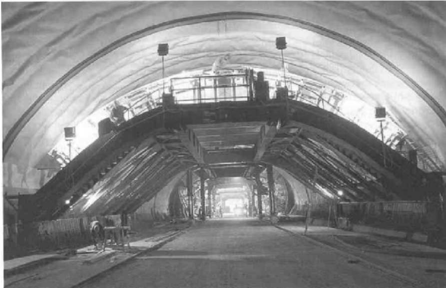
Fig. 5.30. Rolling formwork (Engelberg base tunnel) 26
