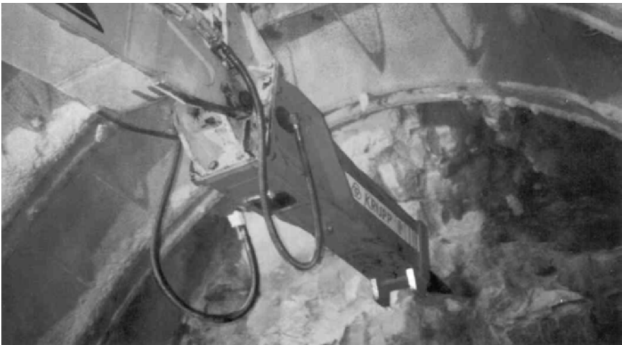
Fig. 4.11. Hydraulic hammer 6
