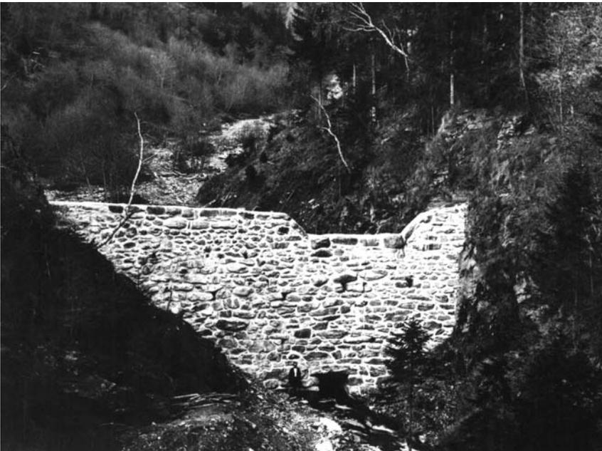
**Figure 18.18.** Solid body barrier, Einachgraben, Austria.
