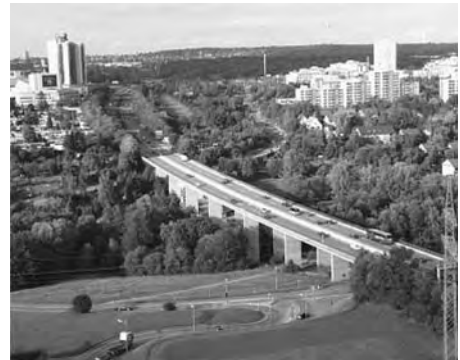
Figure 5. The Koerschtal bridge.
