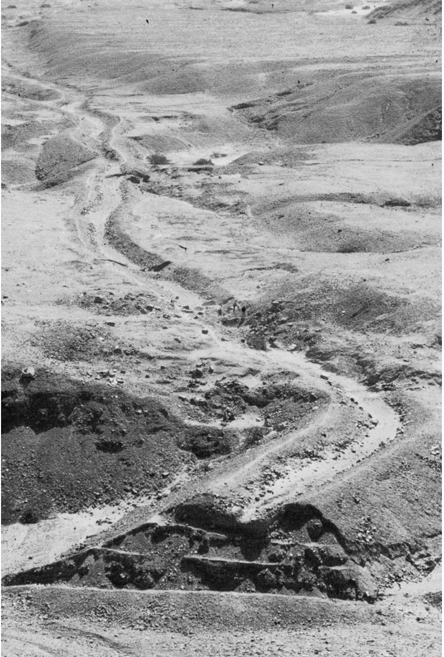
Figure 1.1.15. The Intervalley Canal at Quebrada del Oso.
