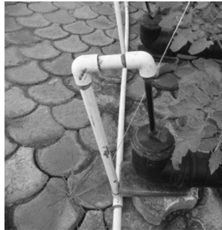
(d) Collector Pipes
