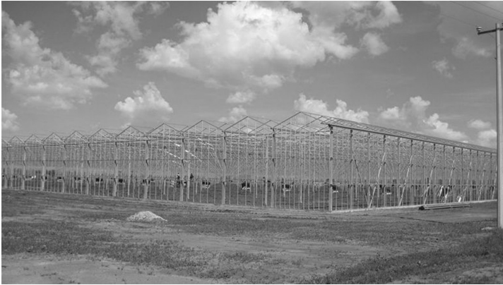
Figure 3.14 Venlo House (Courtesy of Duijnisveld & zn b.v., www.duijnisveld.nl ).
