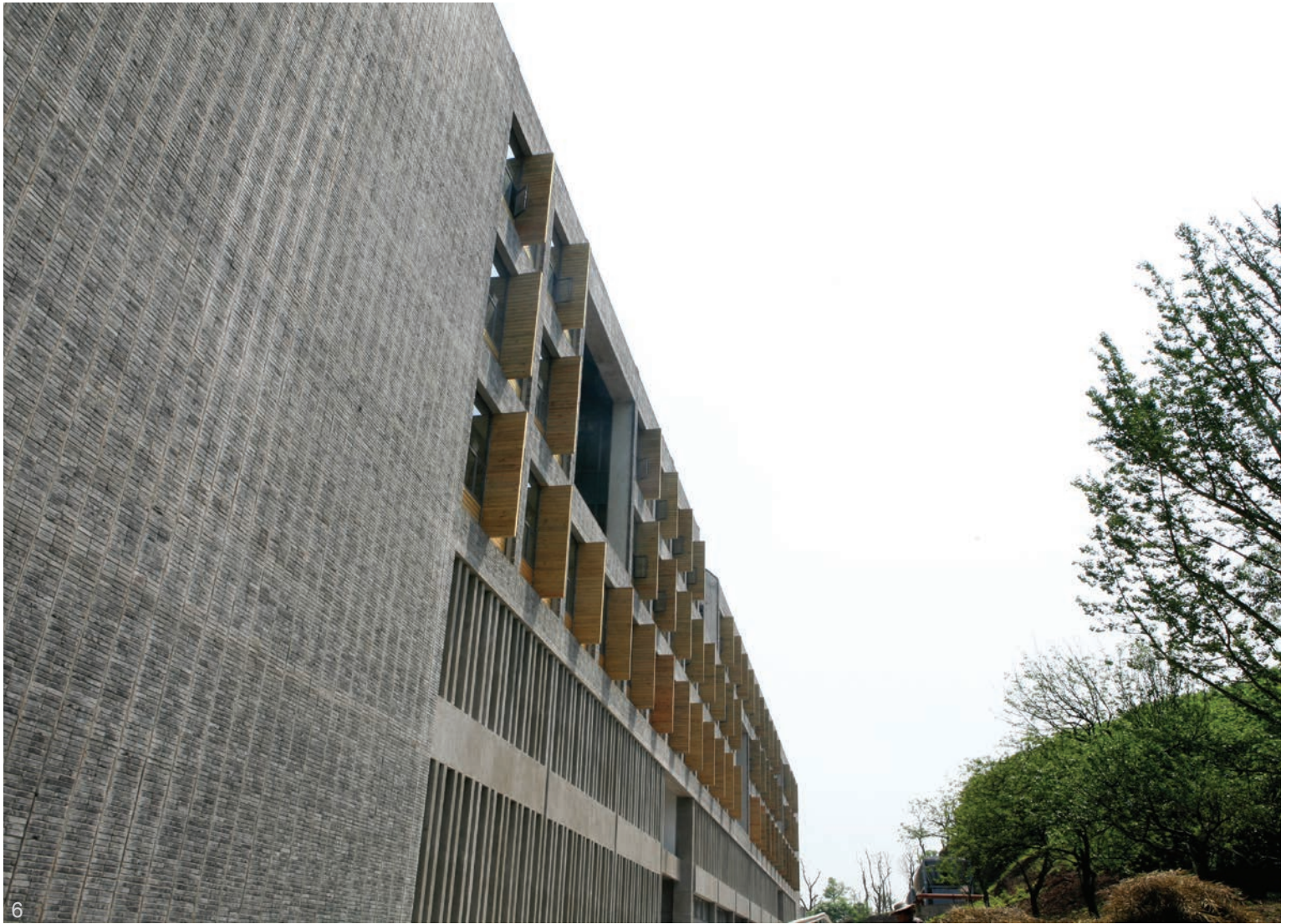
6-8. Main façades with cyan clay bricks 6-8. 建筑主体的外表使用了青色粘土砖
