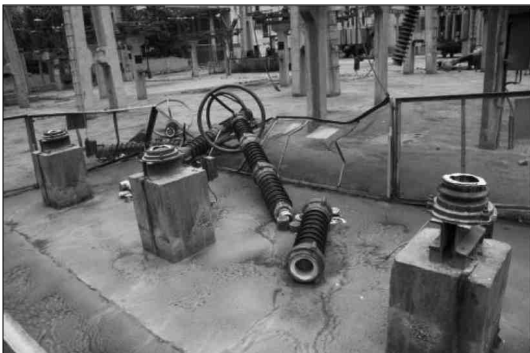
Fig. 4.39. CVT damage
