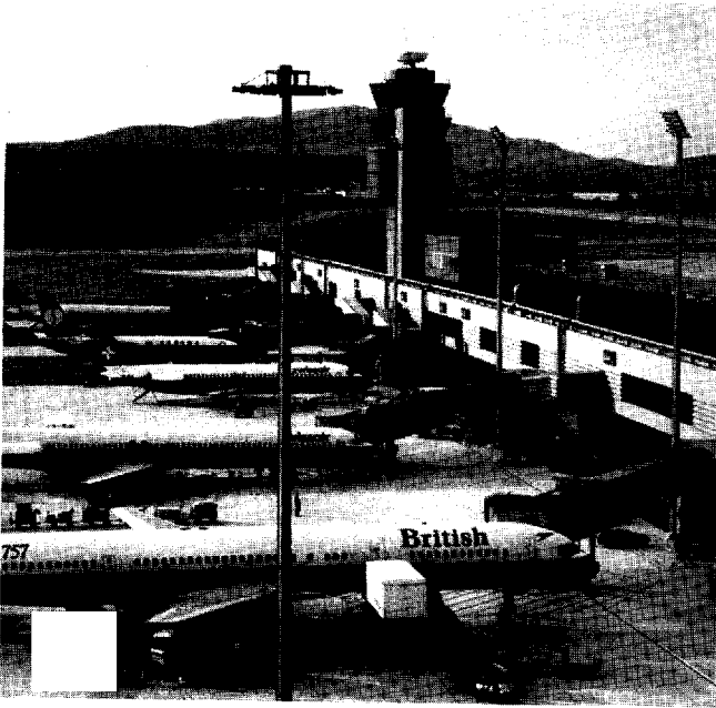
10.4 Zürich Kloten Pier A. Courtesy of Thyssen Henschel.
