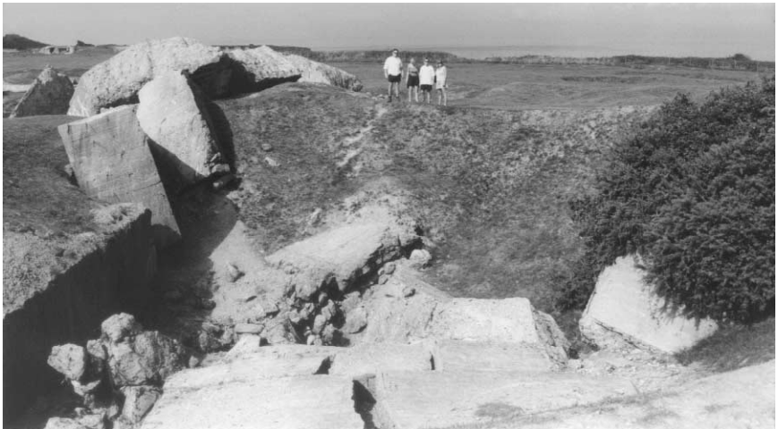
Photo 14.6 Pointe du Hoc, shattered gun emplacement
