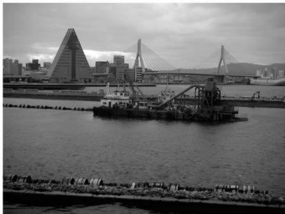
(d) Placement barge.
