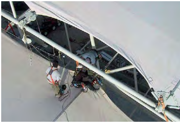
Fig. 354: Tensioning a rope edge
