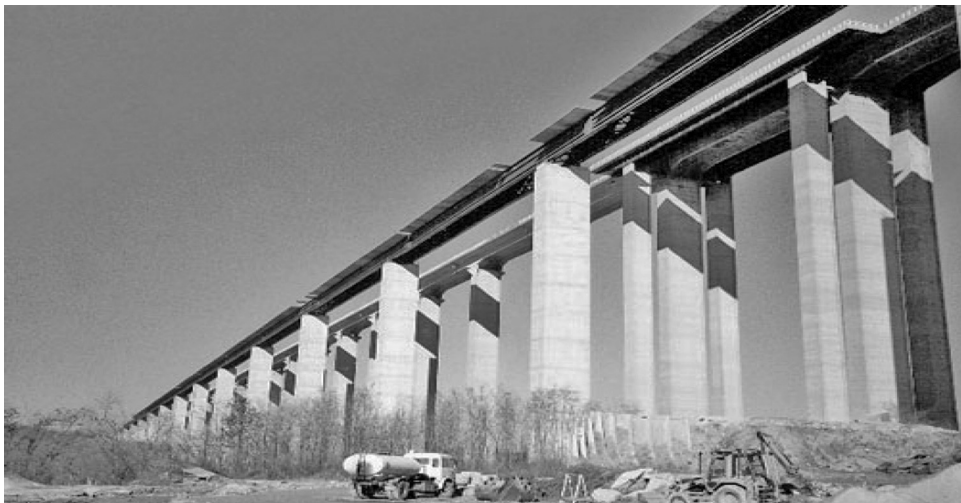
Figure 10.10 The Stura Di Demonte viaduct
