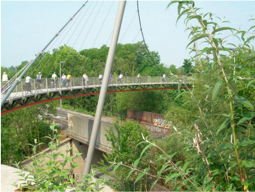
Photo 9.1 Bridge ‘Erzbahnschwinge’ in Emscher Park Radweg cycle track (Photo: Harald Spiering, RVR)
