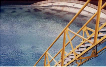
a. Roof sunk.
