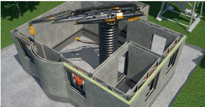
Fig. 1. APIS COR printer ( http://www.apis-cor.com ).
