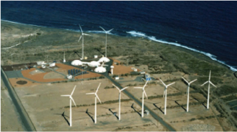
Figure 15.1. Instituto Tecnológico de Canarias (ITC) test facilities at Pozo Izquierdo (courtesy of ITC).
