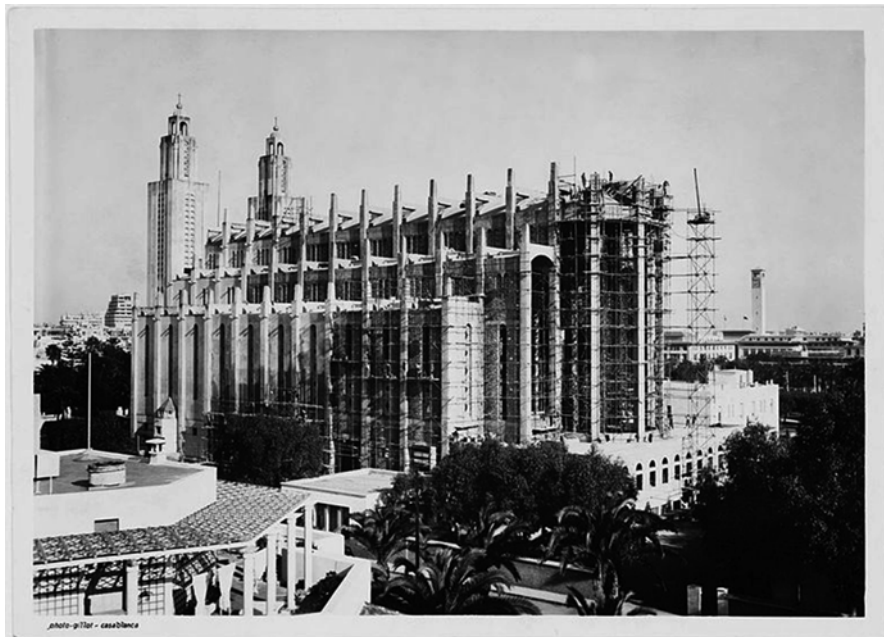
Fig. 7.3 Sacred Heart Cathedral, Casablanca under construction, c., 1930 (Source: Wikimedia.org. http://commons.wikimedia.org/wiki/File:Casablanca,_%C3%A9glise_du_Sacr%C3%A9-C%C5%93ur_vue_du_chantier.JPG )
