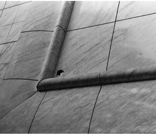
above The translucent marble façade is prone to vandalism and breakage. E.N.S.A.D. – Ecole Nationale Supérieure des Arts Décora- tifs, Paris.
