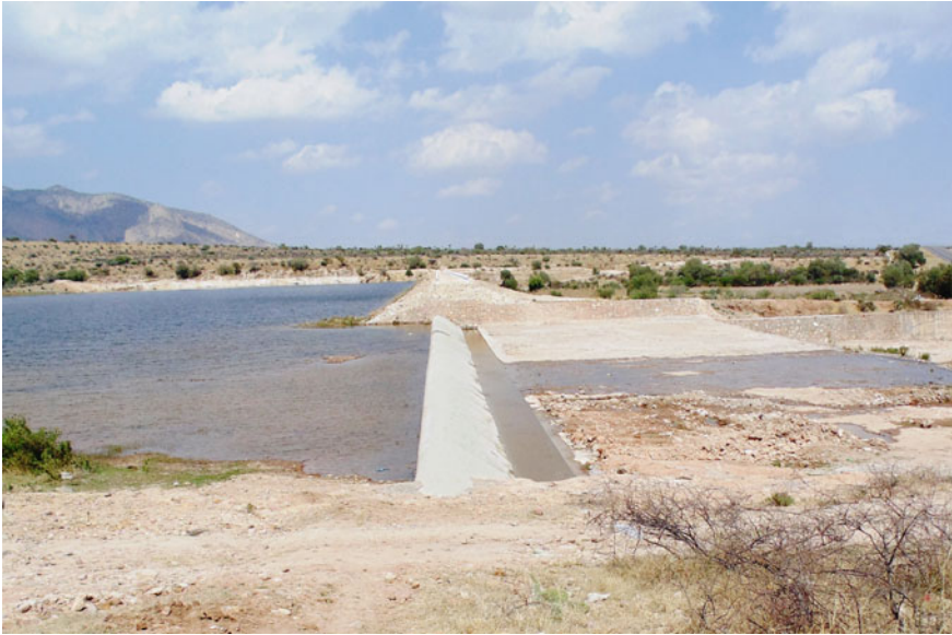
Fig. 9.21 Los Izquierdo Dam in 2014, after rehabilitation (Conagua SISP 2016)
