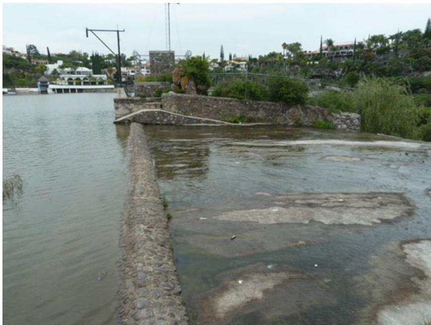
Fig. 9.13 El Cajón Dam spillway in 2013 (Conagua SISP 2016)
