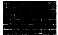
Fig. 45: Header bond
