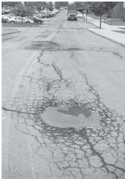
Fatigue crack
