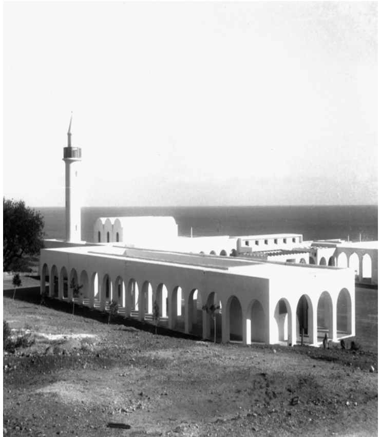
Figure 8.20 One of the villages built for Libyan settlers ( Ente per la Colonizzazione della Libia ).
