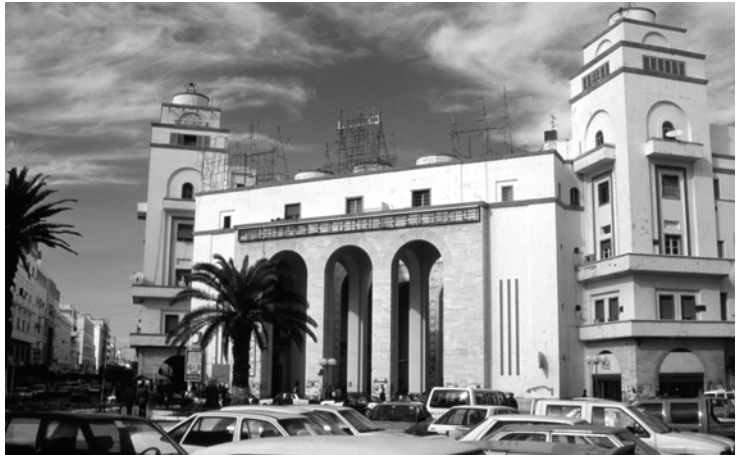
Figure 5.15 Offices of the Istituto Nazionale Fascista per la Previdenza Sociale (National Fascist Welfare Institute) in Tripoli (1938, Architect Florestano di Fausto).
