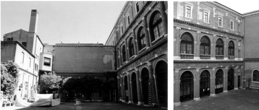
Figure 3-4 Photographs of the 'Chiostro della Carità' in Venice
