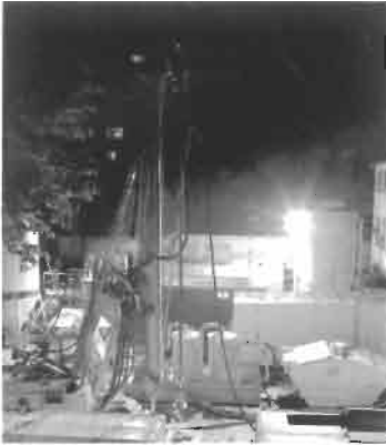
(a) Soil decontamination (Keller Grundbau GmbH, Fallingbostal).
