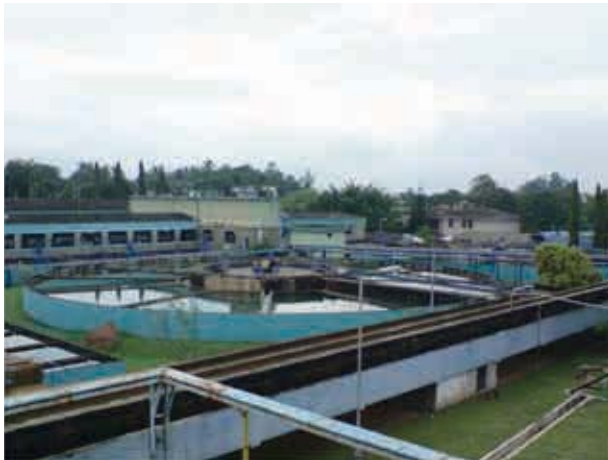
Ambatale Water Purification Plant in Colombo. Photo by A. G. A. N. S. Kumara.
