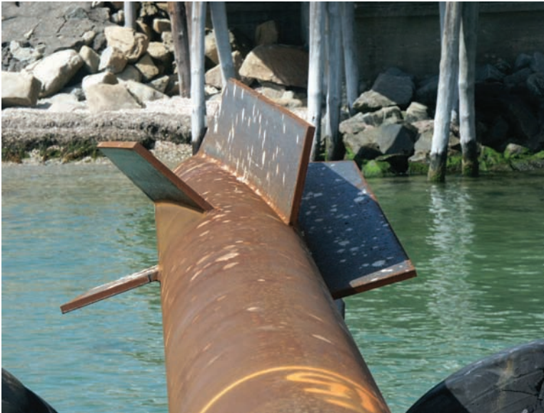
Fig. 8-27. Bottom of SPIN FIN pipe pile
