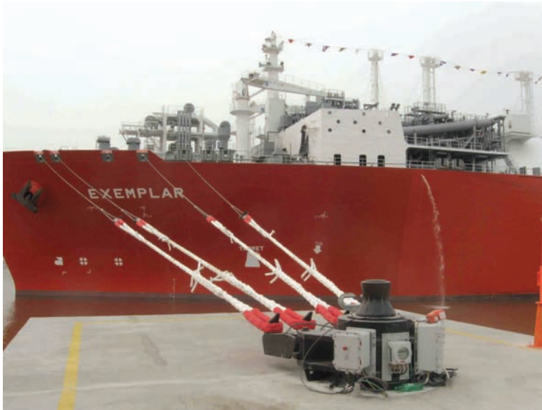
Fig. 6-8. Quadruple quick-release hook at LNG terminal
