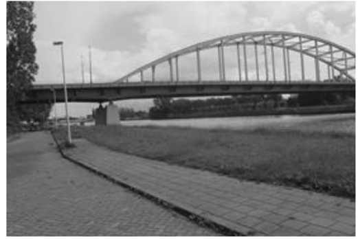
Figure 5. De Meernbrug steel bridge in Utrecht.
