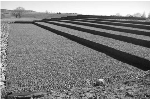
Fig. 7 Gabion spillway
