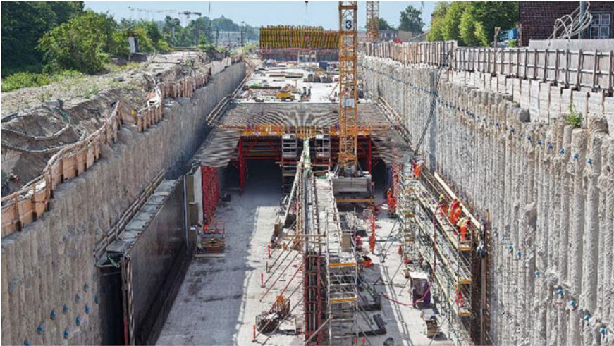
Nordhavnsvej Tunnel, Copenhagen, Denmark, Aug. 2013
