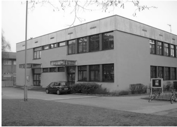
Fig. 7 Sonderschulen 6 in 2009 just before renovation, Credit: Immobilien Linz GmbH & Co KG and Fotostudio Meister Eder
